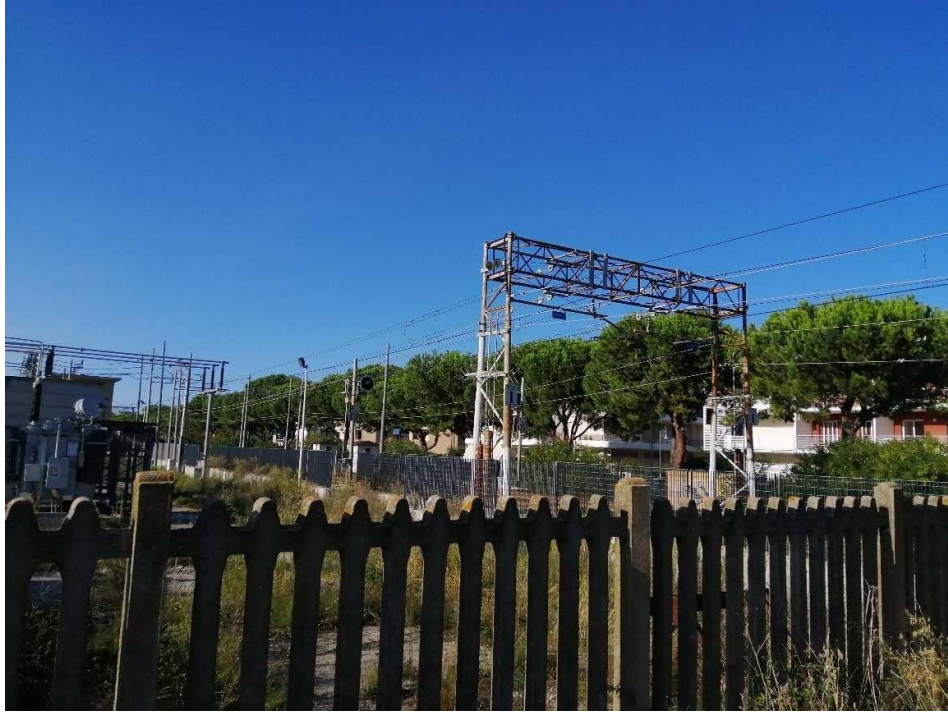
FOTO 5. Vista dei portali tralicciati
