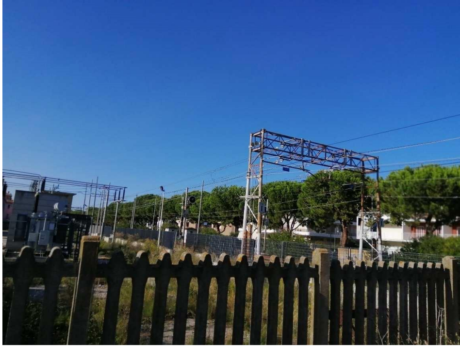
FOTO 3. Vista dei portali tralicciati
