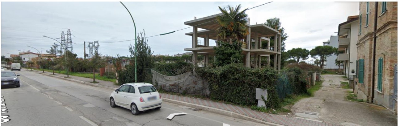
FOTO 29. Vista del fabbricato e della recinzione della proprietà dal marciapiede opposto
