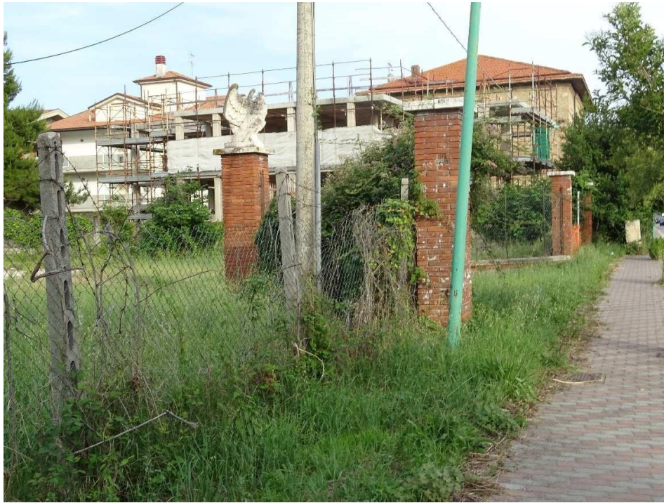
FOTO 26. Vista del fabbricato e dell'ingresso sud
