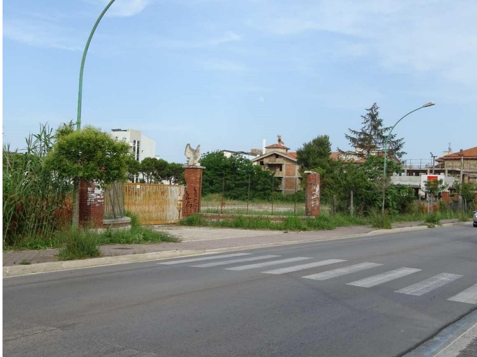
FOTO 22. Vista dell'ingresso lato nord dal marciapiede opposto
