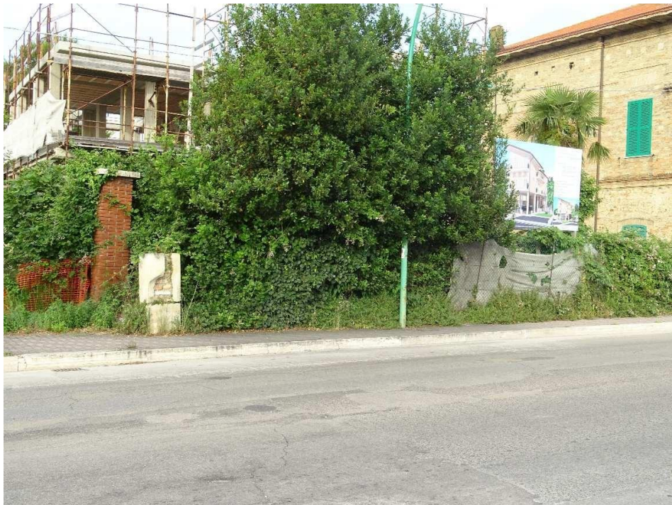
FOTO 25. Vista del fabbricato dal marciapiede opposto
