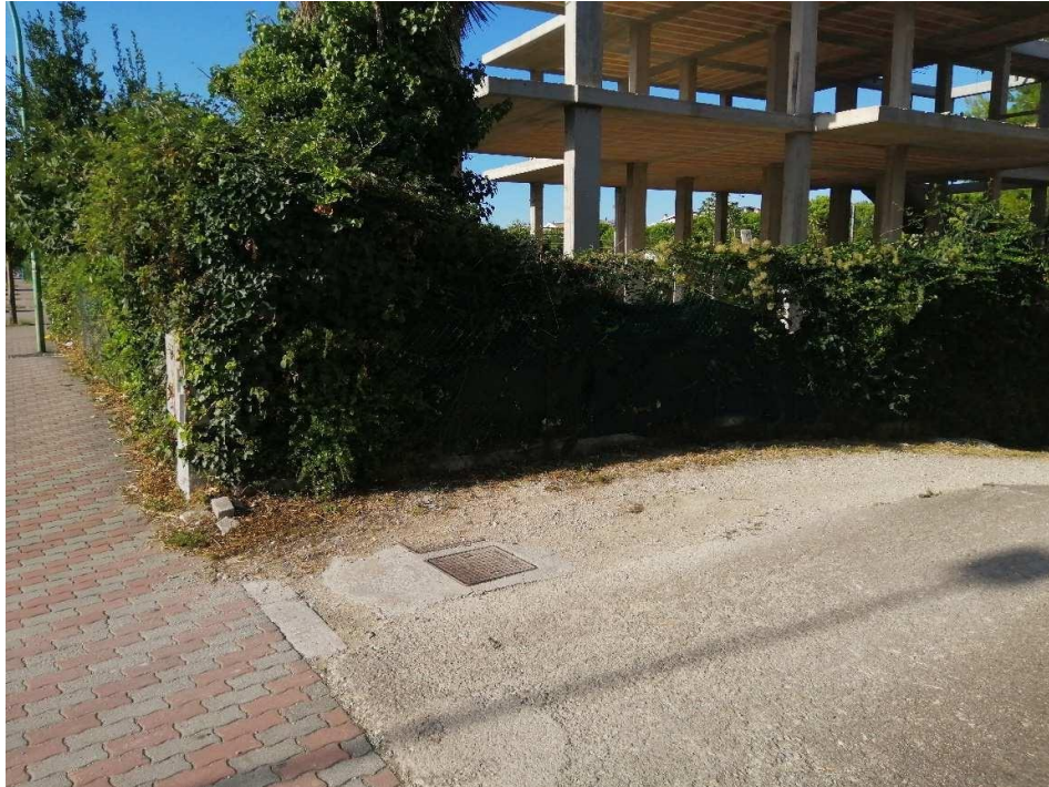
FOTO 11. Vista del limite di proprietà e del fabbricato esistente
