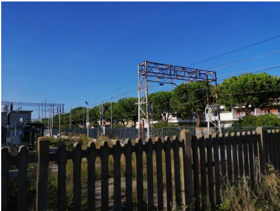
FOTO 4. Vista dei portali tralicciati
