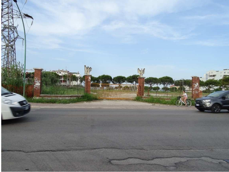
FOTO 22. Vista dell'ingresso lato nord dal marciapiede opposto
